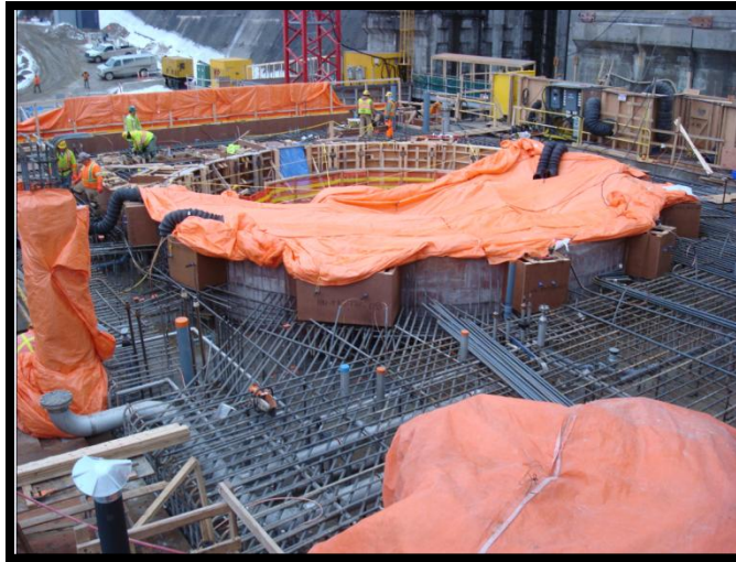
Figure 2: Harmon Generator Floor Pour
