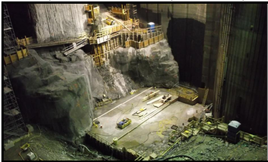
Figure 3: Kipling mud slab pour
